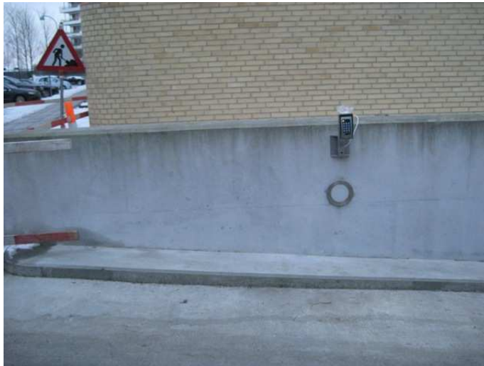
Elektronisk nøglelæser i Parkhuset
